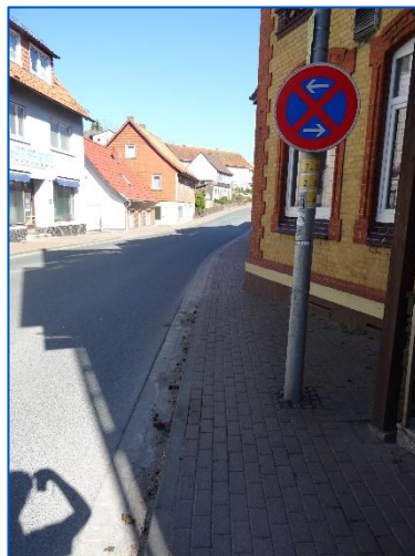
Gehwegengstelle (Obere Hilsstraße)
