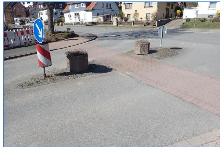
Mangelhafte Querungsanlage (Teure Zeit)
