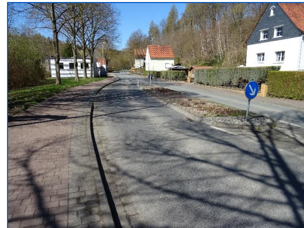
Mangelhafte Querungsanlage (Hilsstraße)
