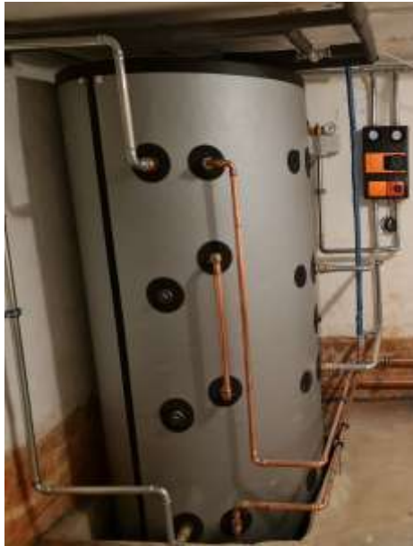
Einbau Pufferspeicher
