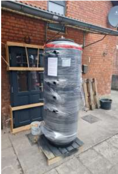
Einbau Pufferspeicher
