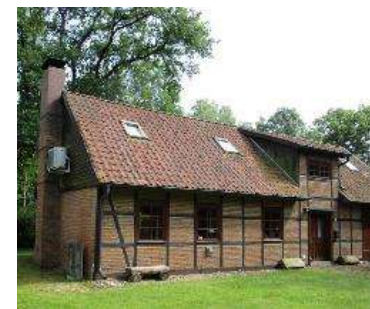
110 m 2 Sehr wenig gedämmt 4 Luft-Luft-Wärmepumpen 18 kW
