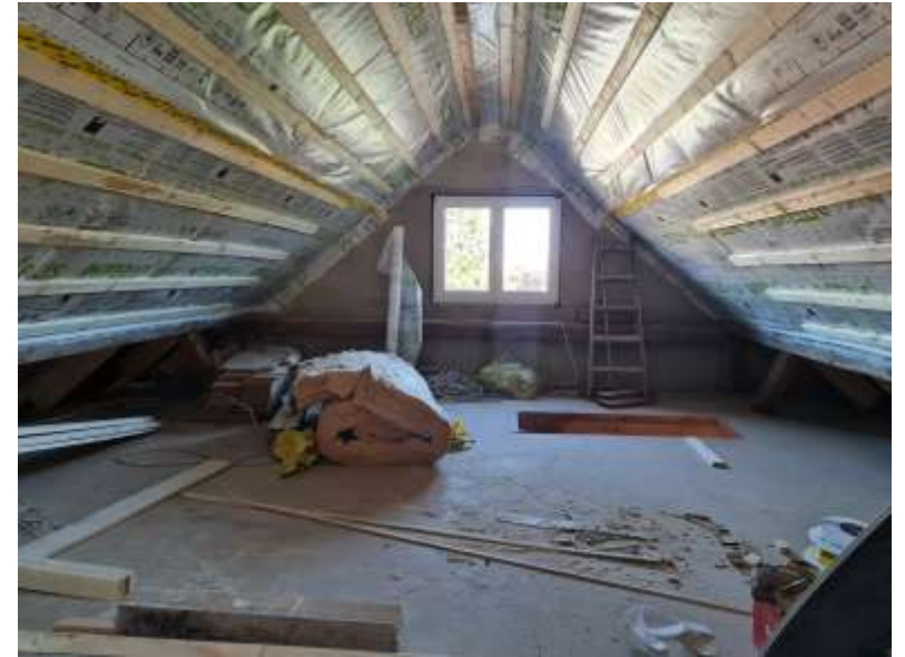
Dämmung Dach Stallanbau
