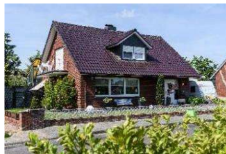
140 m 2 Mäßig gedämmt Normale Heizkörper 14 kW
