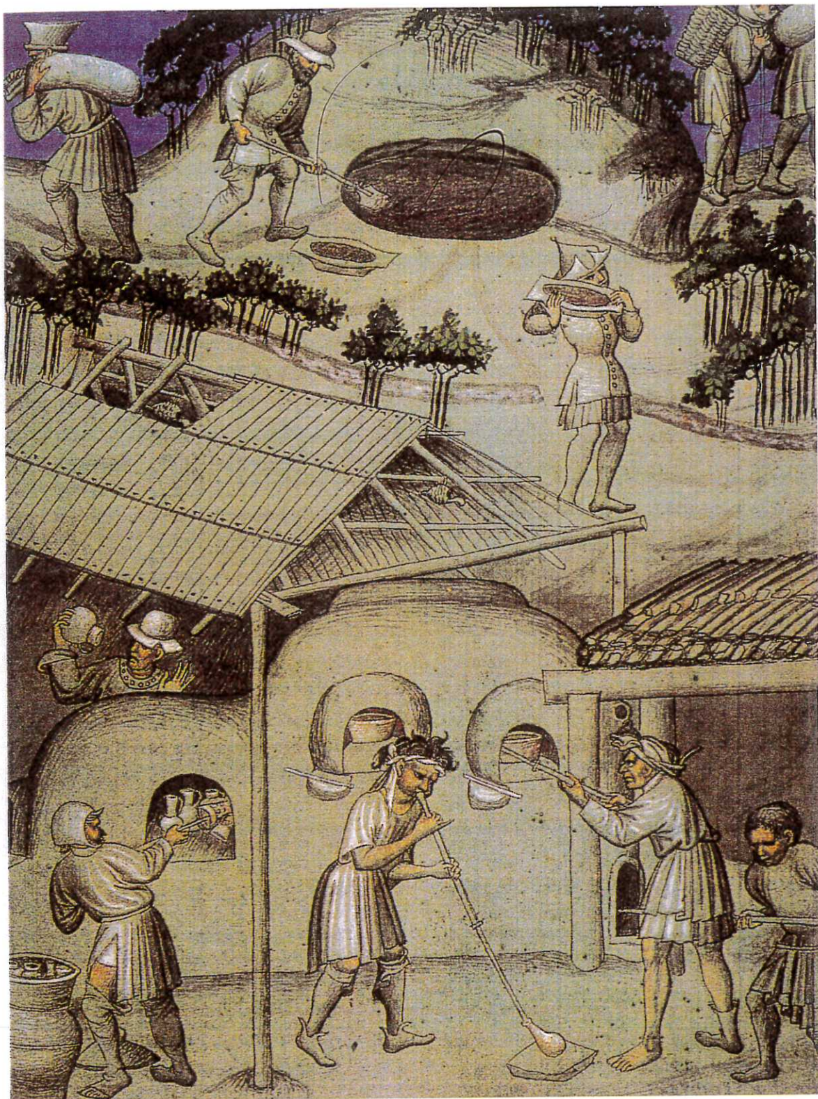
Abb. 4: Mittelalterliche Glashütte, um 1400, Miniatur aus der Reisebeschreibung des Sir John Mandeville. The British Museum London, Add.Ms. 24189, fol. 6. Neben den Arbeitsöffnungen sind Schalen angebracht.
