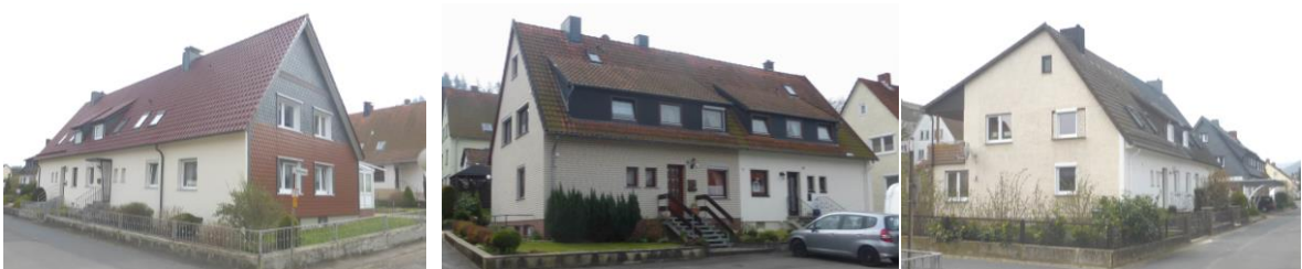
Abbildung 42: Typische Doppelwohnhäuser im Stile der 1950/60er Jahre im Rosenweg, zum Teil einseitig zweigeschossig aufgestockt und zum Teil verändert mit Klinker- und Vorhangfassaden.
