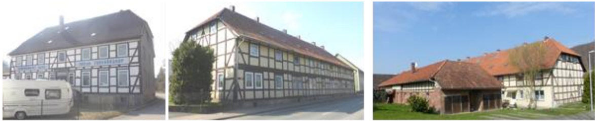
Abbildung 27: Beispiele zu Fachwerkhäusern
