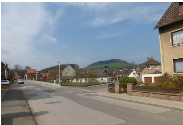
Abbildung 82: Schulstr. mit Blick in den Straßenzug Hinter dem Wasser (unsanierter Zustand)
