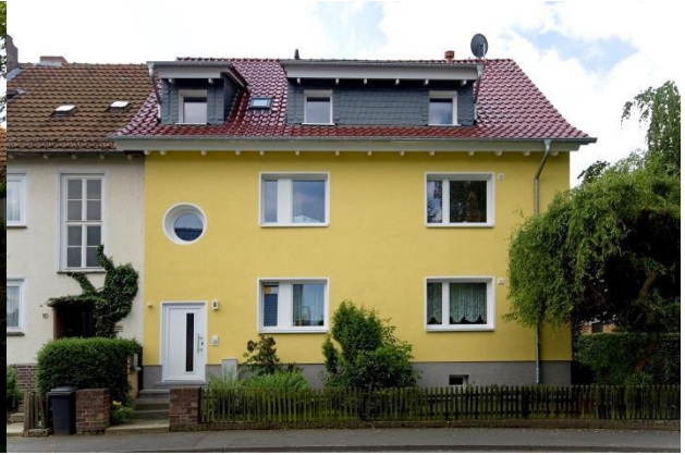
Abbildung 114: Vorderseite des Gebäudes (saniert) Quelle: (dena)
