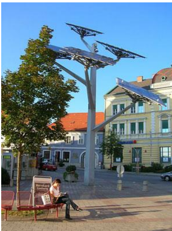
Abbildung 136 Solarbaum mit fest stehenden Modulen
