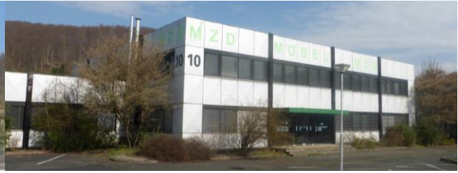
Abbildung 64: ehem. Möbelhaus Dr.-Jasper-Str. 10
