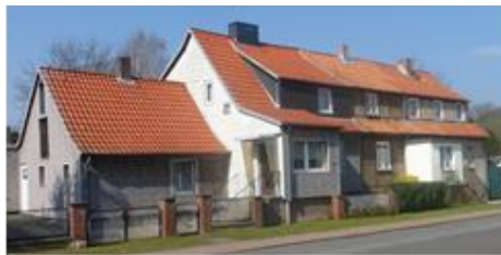
Doppelwohnhaus Göttinger Straße 12-14 Mischstrukturen im Fassadenbereich
