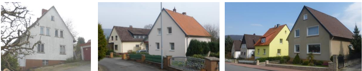
Abbildung 43: Siedlungshaus am Veilchenweg (noch mit z.T. ursprünglichen unterteilten Holzfenstern - Foto ganz links), Wohnhäuser an der Jahnstraße (Foto Mitte) und August-Reuter-Straße
