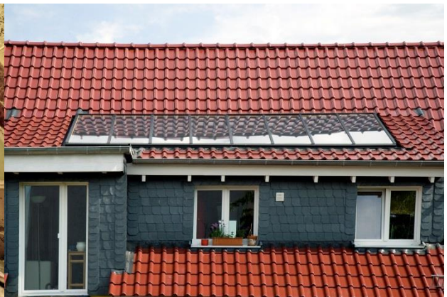
Abbildung 116: Solarthermische Dachanlage in Südrichtung Quelle: (dena)
