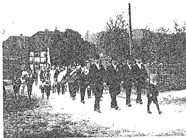
Dorffest in Varrigsen in den 20er Jahren (noch mit Kalkstein-Schotterstraße).
