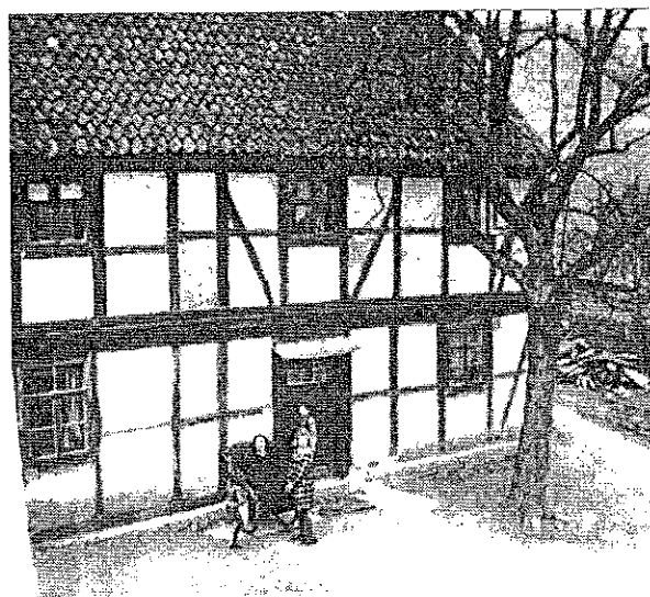
Das alte Gesindehaus (heute ist dort die Bushaltestelle mit dem Telefonhäuschen).
